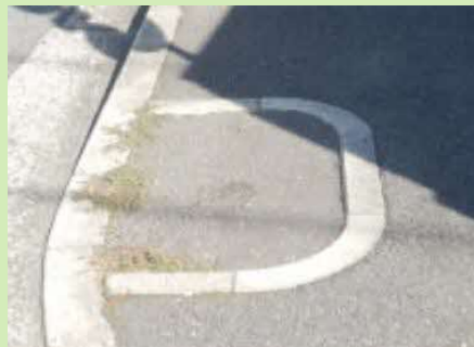
伐採後処理例(真砂土もしくはアスファルトにて処理)
