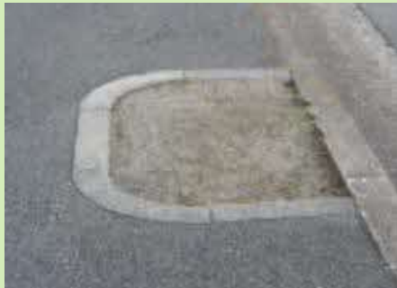
伐採後処理例(真砂土もしくはアスファルトにて処理)
