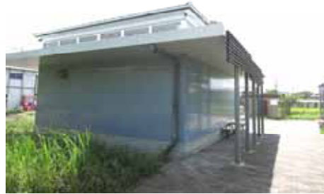
公園の備蓄倉庫
