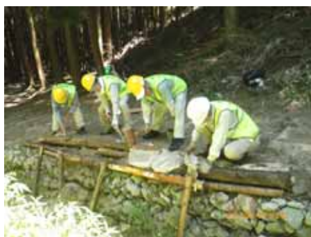
里山での作業道の整備
