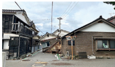
▲隣同士でも損壊状況が違う家屋
