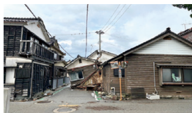
▲隣同士でも損壊状況が違う家屋
