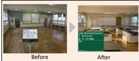
【津田中学校 調理室改修】
