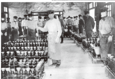
禁野火薬庫の内部
