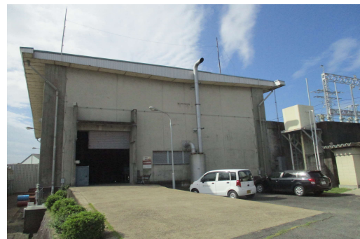
<北部ポンプ場外観>
