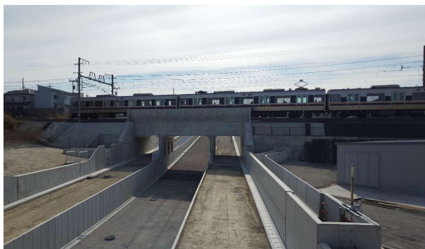
牧野長尾線 道路整備工事
