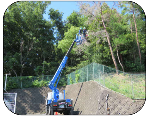
高所作業車による緑地の樹木剪定
