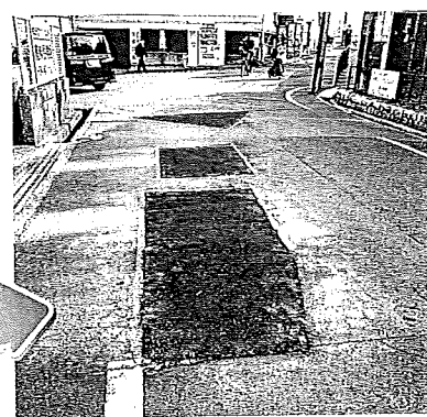
牧野駅前道路補修後
