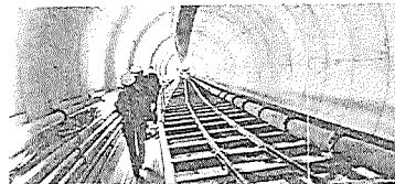
▲整備が進む桶狭雨水貯留施設 市に導入された電気自動車▶
