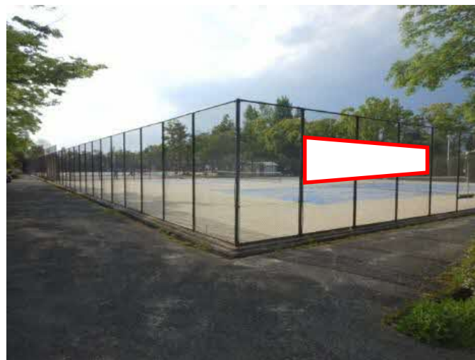
【設置例②】 フェンス
