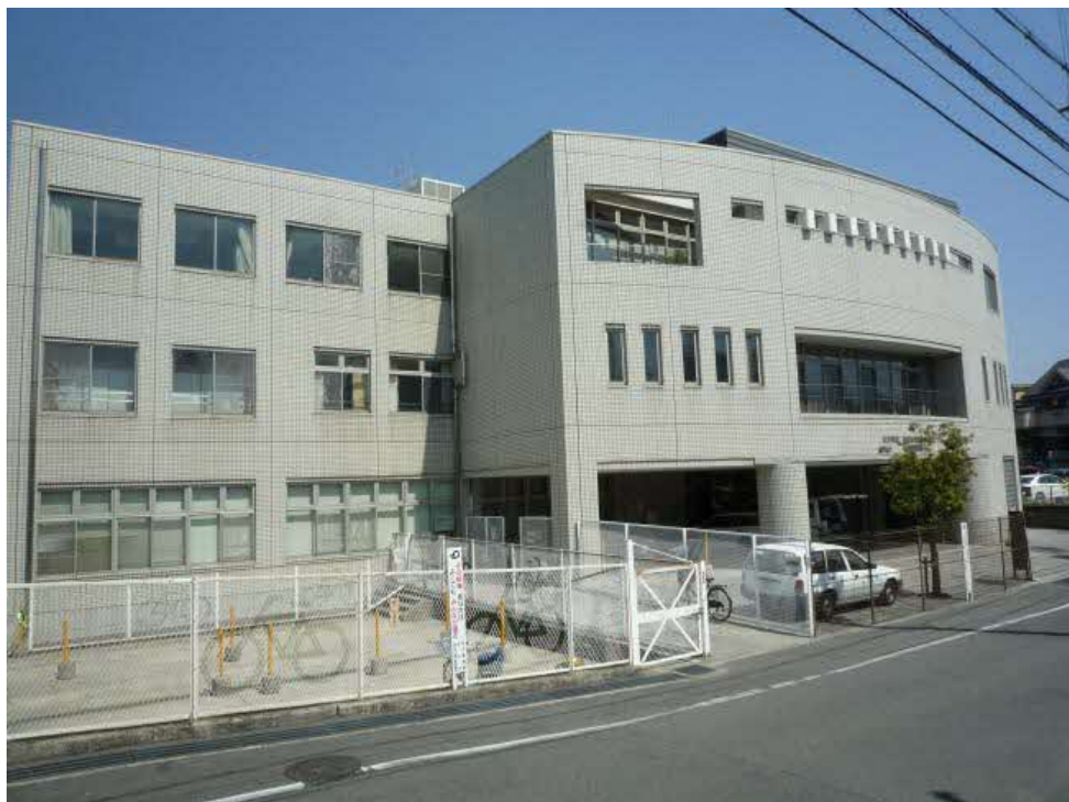
【牧野生涯学習市民センターの外観】
