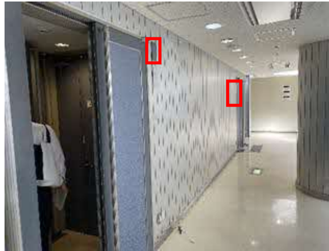
【ホール前廊下】
