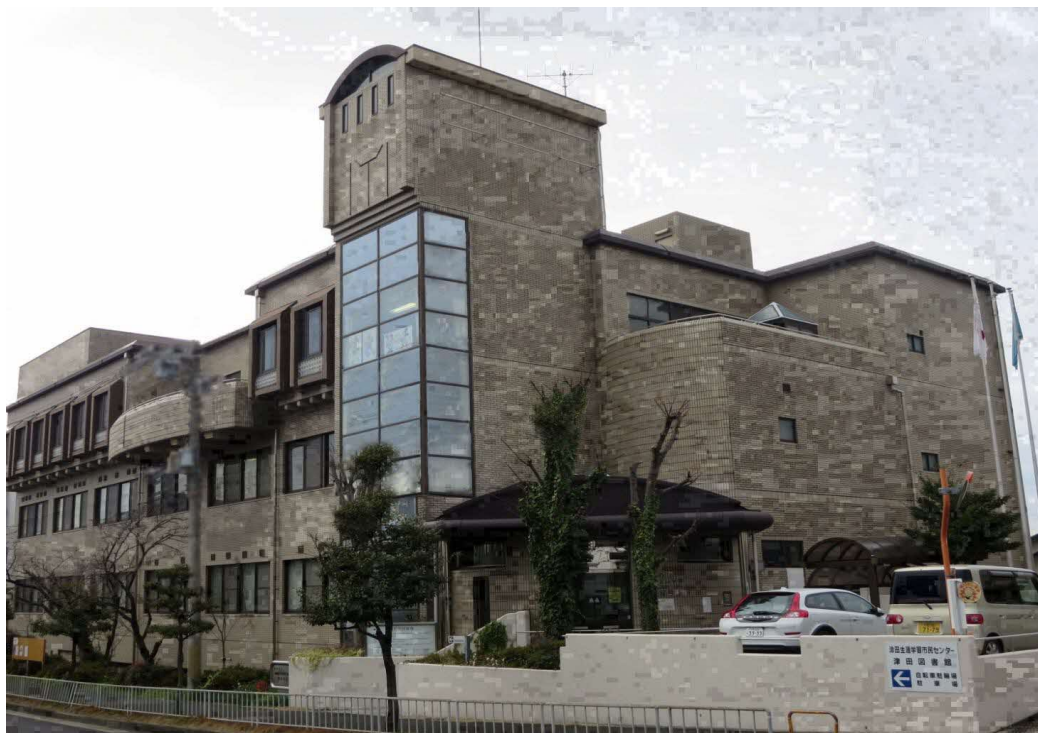
【津田生涯学習市民センターの外観】
