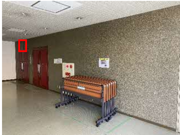
【ホール前廊下】
