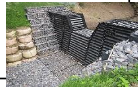
治山ダム設置前・後
