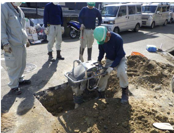
《道路陥没の復旧作業》
