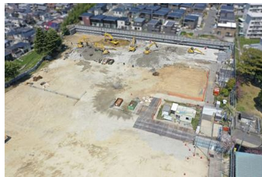
(解体状況 令和5年4月時点)
