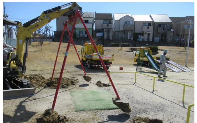
《老朽化に伴うプランコの入替え作業》
