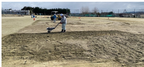
(グラウンド改修中)
