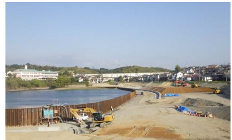
《長尾大池周辺区間の整備工事》
