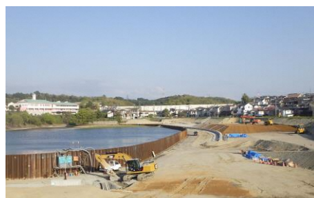
《長尾大池周辺区間の整備工事》
