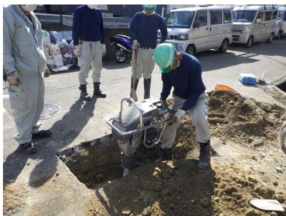
《道路陥没の復旧作業》
