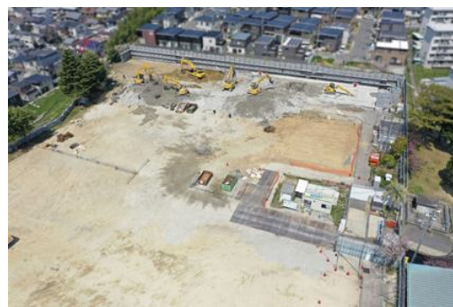
(解体状況 令和5年4月時点)
