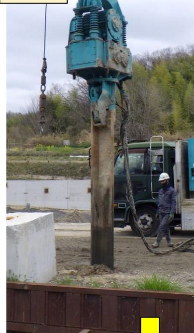
バイブロハンマ工法による鋼矢板の打ち込み
