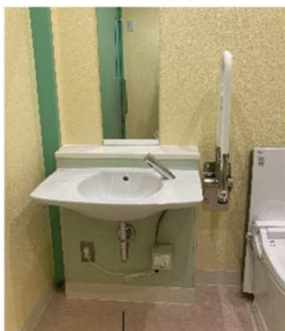
車いすでひざ下が入るスペース
