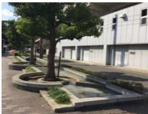
都市計画道路京阪南 2 号線の高架側道の歩道に設けられたせせらぎ水路
