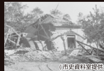
爆風で倒れた火薬庫
