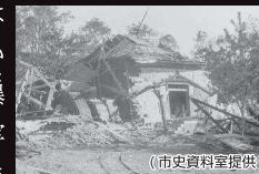
風暴で倒れた火薬庫 (市史資料室提供)
