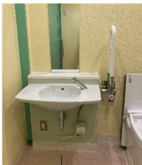
車いすでひざ下が入るスペース
