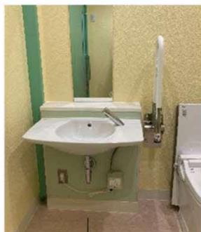
車いすでひざ下が入るスペース
