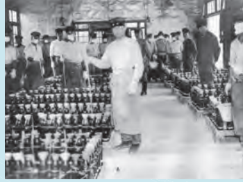
▲禁野火薬庫の内部
