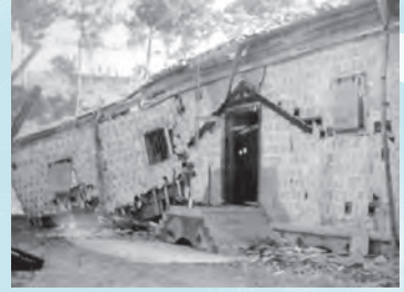
▲爆発で崩れた禁野火薬庫
