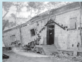
▲爆発で崩れた禁野火薬庫
