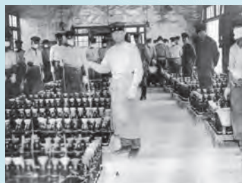
▲禁野火薬庫の内部
