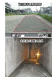
走谷雨水調整池
