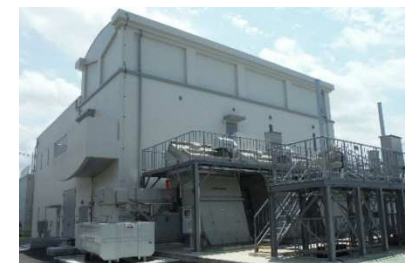
新安居川ポンプ場外観
