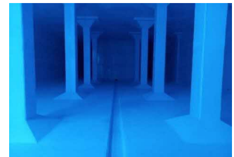
2号池内部の様子 耐震補強及び防水工事を行いました。
