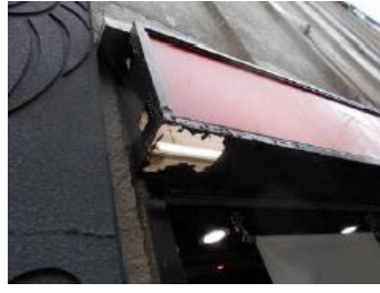
側板の腐食
