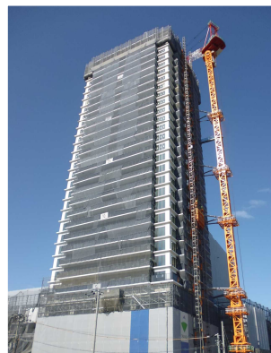
▲ 建築が進む「第4街区」の建物(11月)。今はクレーンはなくなっている
