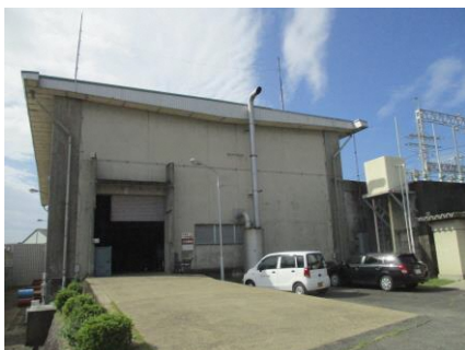
<北部ポンプ場外観>
