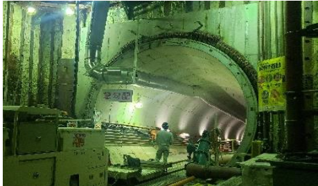
＜築造中の楠葉雨水貯留管＞
