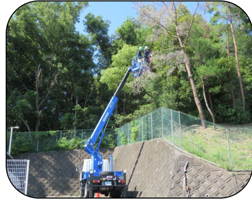
高所作業車による緑地の樹木剪定
