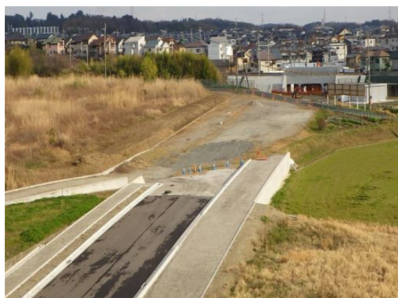
牧野長尾線 道路整備工事
