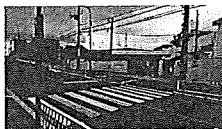
拡幅された歩道と横断歩道
