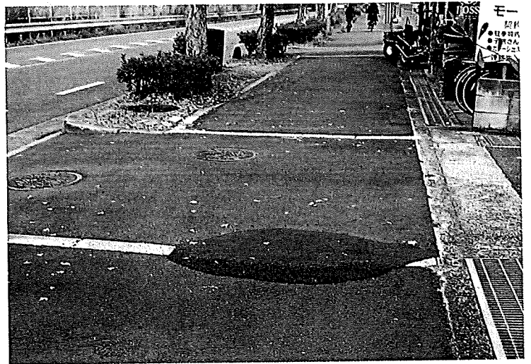
出口4丁目 美容室前歩道、高齢者の転倒多発の為、陥没段差補修完了(令和3年12月)
