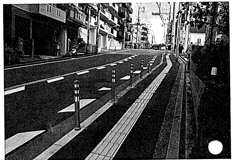
東中振2丁目 歩道に通学路の安全対策の安全ポールを設置する。 (令和3年11月)
