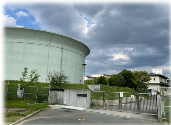
— 田口山配水場 —
