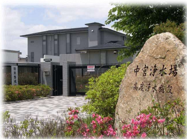
— 中宮浄水場高度浄水施設 —
