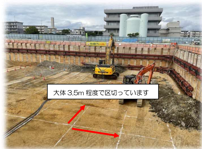
— 地盤改良の範囲を白線でブロック分け —
