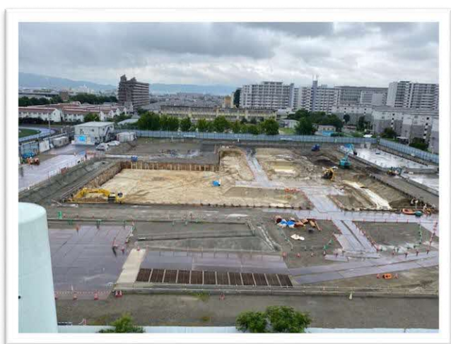
中宮浄水場更新用地 令和6年7月2日撮影
