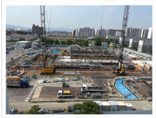
中宮浄水場更新用地 令和7年7月1日撮影
