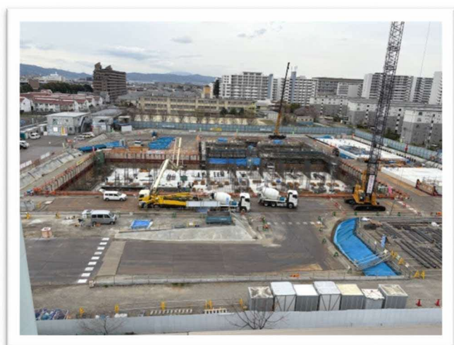
中宮浄水場更新用地 令和7年4月2日撮影
