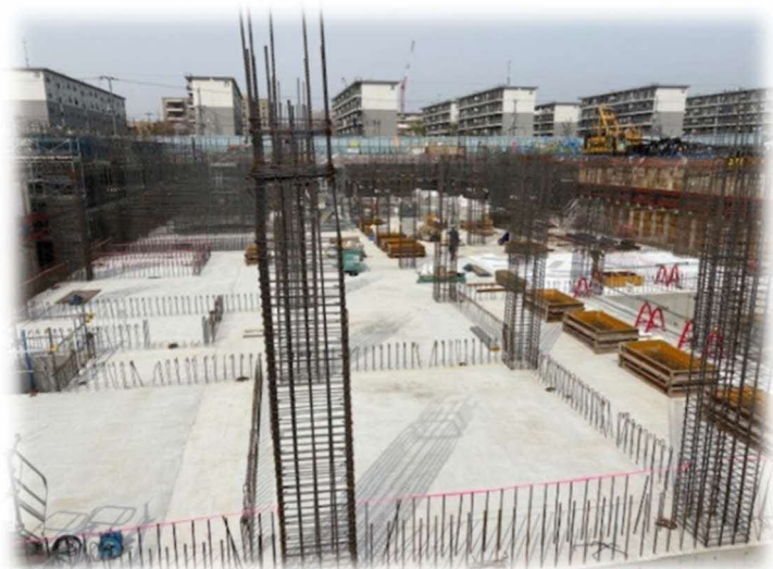
— コンクリート（完了） —
