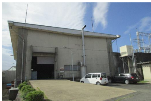
<北部ポンプ場外観>
