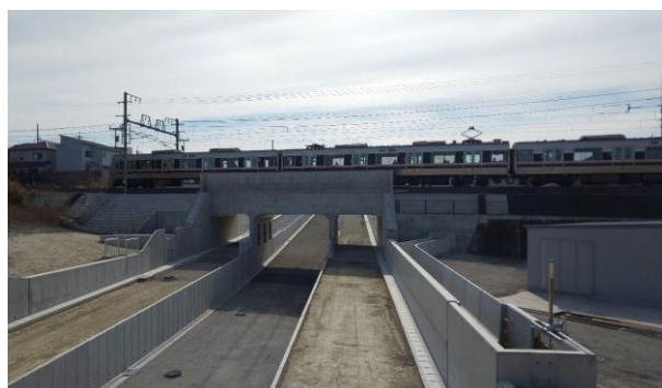
牧野長尾線 道路整備工事
