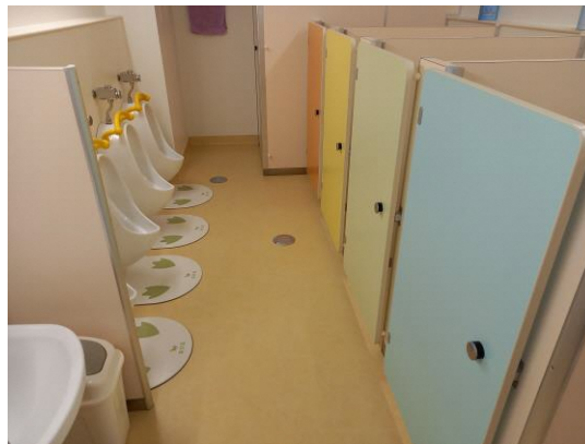
（トイレ改修事業）
