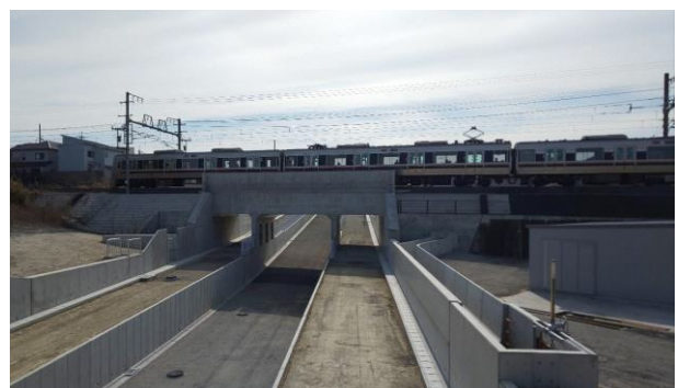
牧野長尾線 道路整備工事
