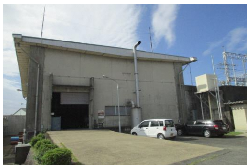
<北部ポンプ場外観>
