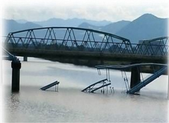
（和歌山市水管橋崩落事故の様子）
