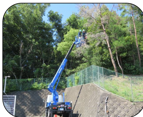
高所作業車による緑地の樹木剪定
