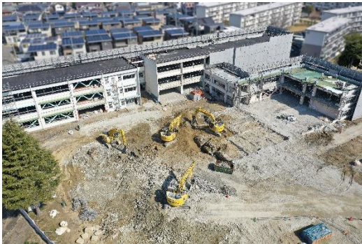
（左写真：管理棟解体工事の様子）
