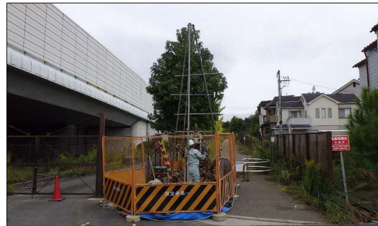
標準貫入試験（ボーリング調査）
