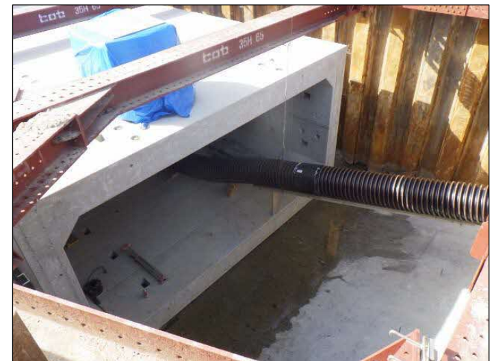
製品を追加しボックスカルバートを延長
