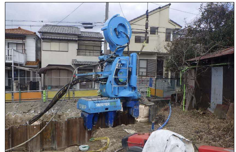
ウォータージェット併用圧入工法
