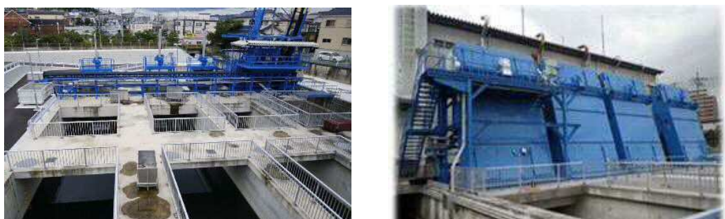
図3.4 完成した溝谷川ポンプ場の沈砂池(左)と除塵設備(右)
