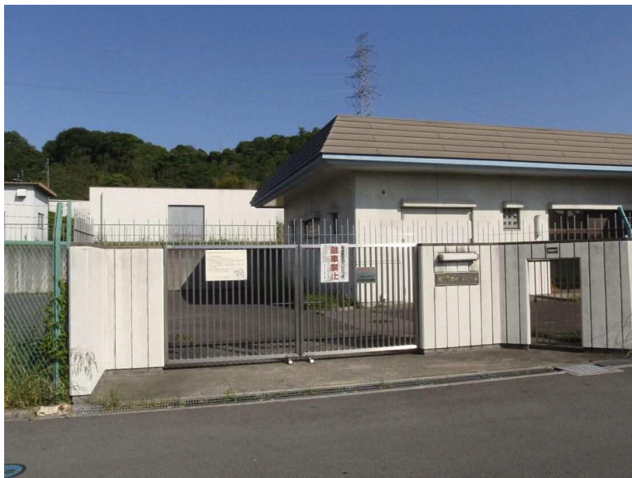
図 7.5 津田低区配水場
