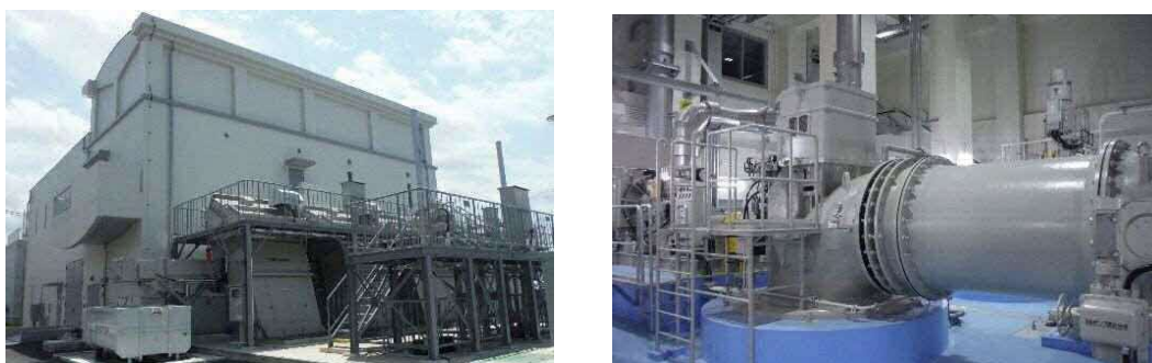
図3.3 完成した新安居川ポンプ場の外観(左)とポンプ本体(右)
