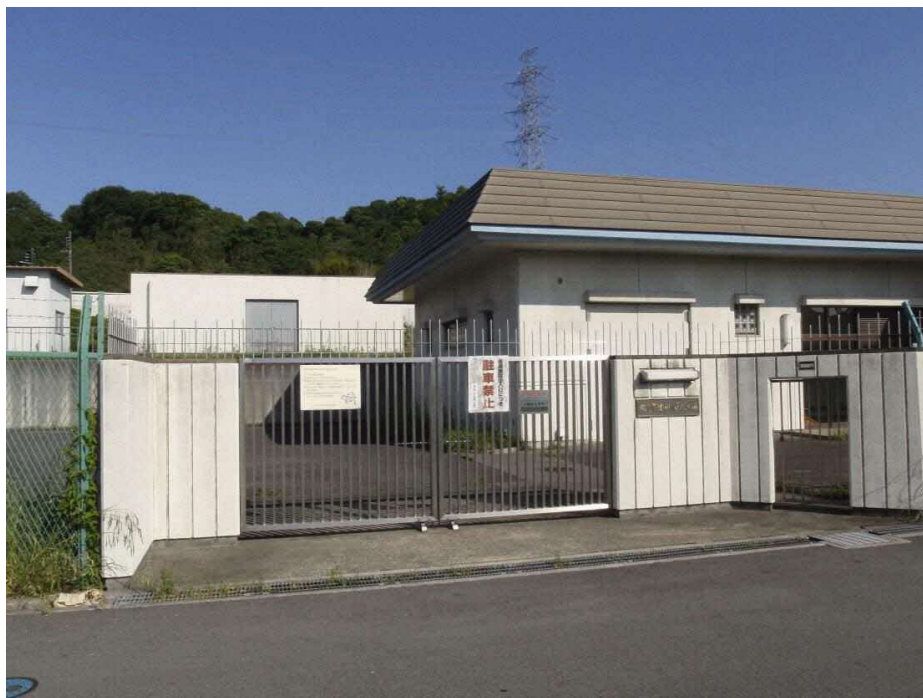
図 7.5 津田低区配水場
