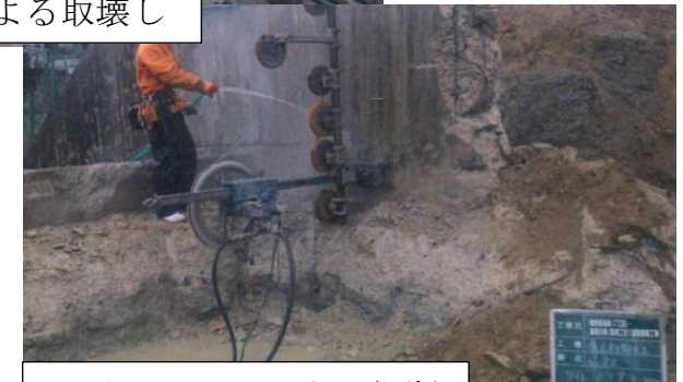
ワイヤーソーによる切断
