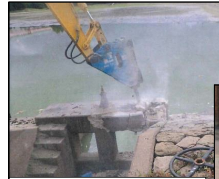
ブレイカーによる取壊し
