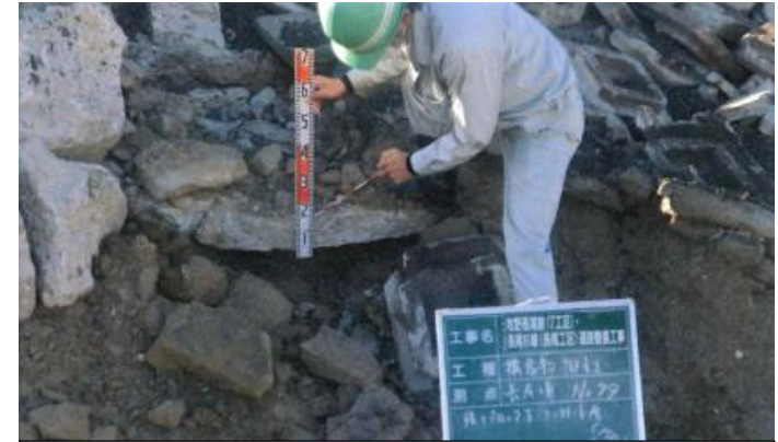
張ブロック下コンクリート確認状況
