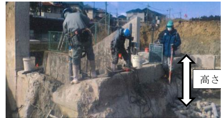
既設余水吐底板コンクリート確認状況
