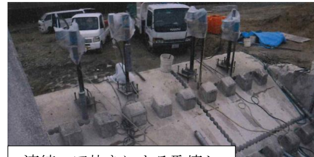
連続コア抜きによる取壊し
