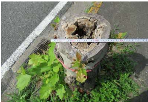
写真14 空洞ができた街路樹の事例
