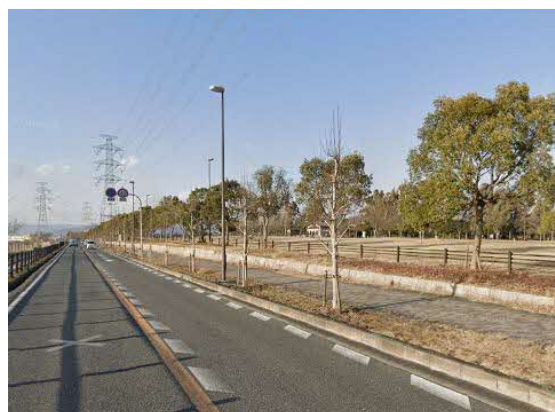
写真24 隣接地が公園となっている街路樹
