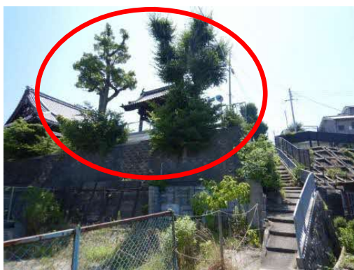
写真20 ブロック積み擁壁天端に 植栽された街路樹
