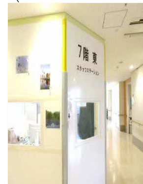
オープン詰所前に壁を設置
