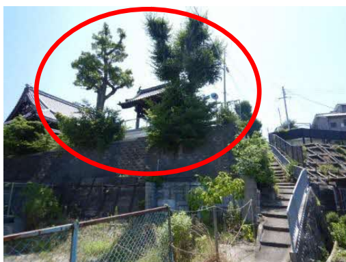
写真20 ブロック積み擁壁天端に 植栽された街路樹
