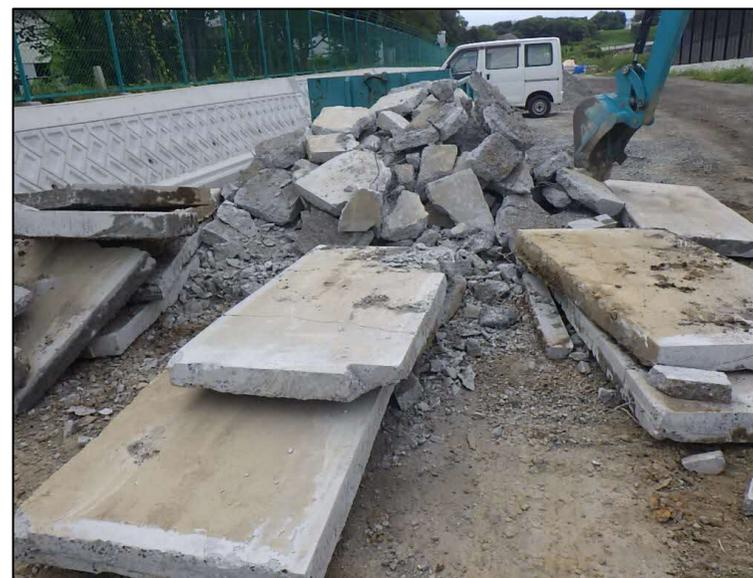
●L型擁壁施工箇所を掘削時にコンクリート版を確認したため、撤去処分した。
