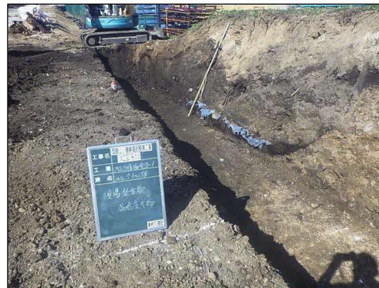
● 施工箇所の広範囲で掘削時に混合廃棄物を確認したため、撤去処分した。
